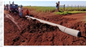
INSTALACIÓN DE TUBOS DE ALCANTARILLA EN PANAMBI
