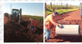
INSTALACIÓN DE TUBOS DE ALCANTARILLA EN PANAMBI
